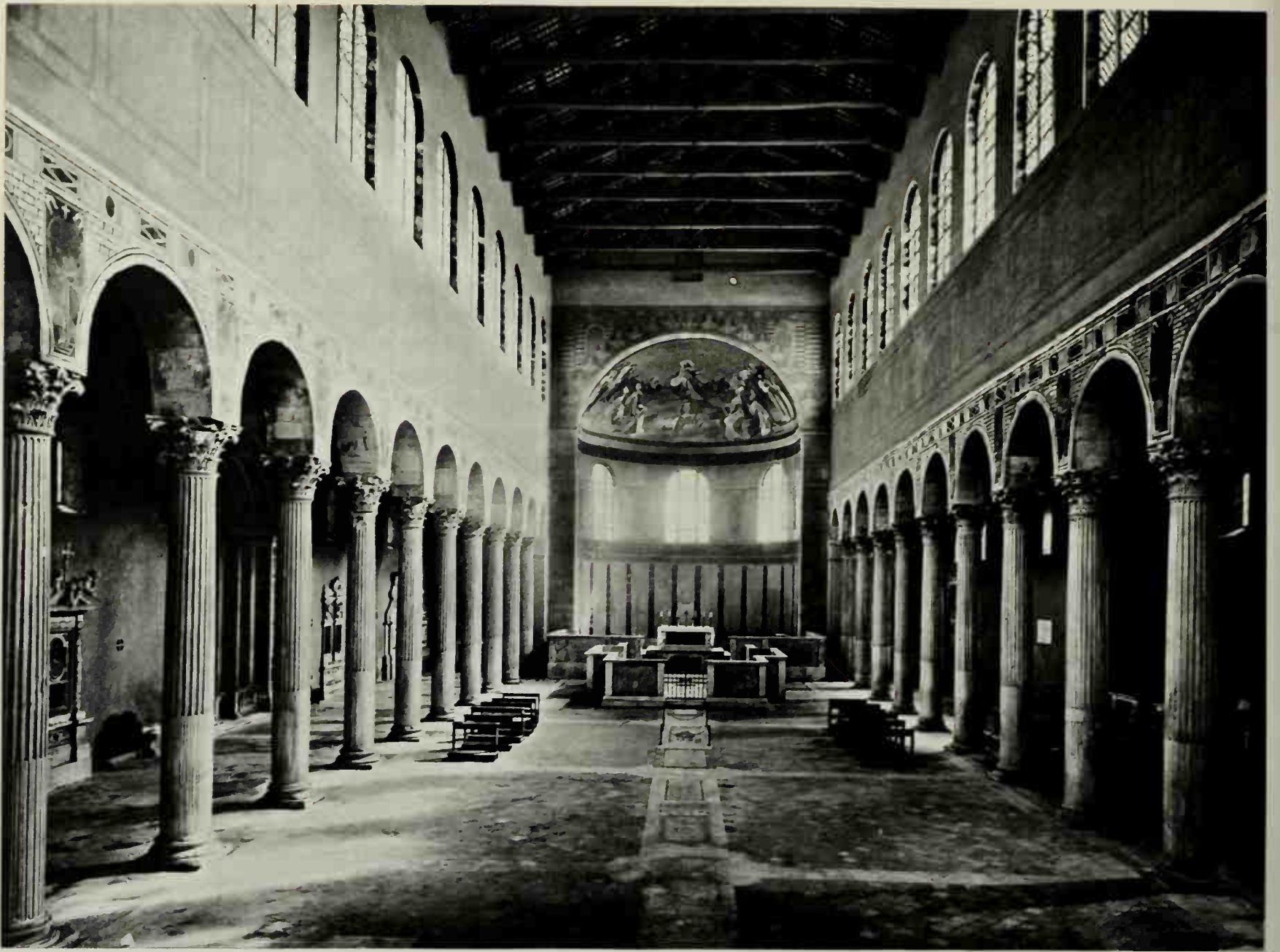
323. Interior. Sta. Sabina. 422-32 A.D. Rome
