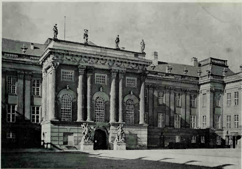
(A) Georg Wenzeslaus von Knobelsdorff; Potsdam, Stadtschloss, 1744–51. Court side (before destruction)
