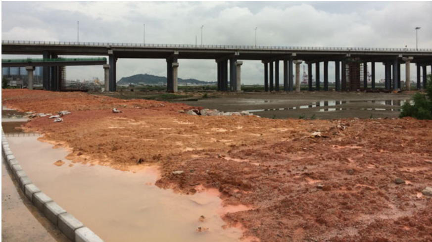
Fig. 1.6 A construction site
