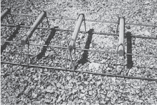
FIG.1. Dowel bar basket (FHWA 1990).
