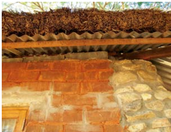
{ FIG. 3.35 } O uso sem protecção (isolamento) de material metálico para coberturas deve ser evitado, dado que leva ao agravamento de situações de sobreaquecimento interno.
