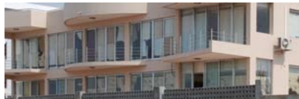
{ FIG. 3.38 } Devem ser evitadas tipologias de fachadas com grandes áreas de envidraçado, largamente responsáveis pelo sobreaquecimento do interior do edifício, e conseqüente recurso a sistemas energívoros de ar condicionado. As fachadas com grandes áreas de envidraçado são uma tipologia importada, não se adequando ao clima quente de Moçambique.
