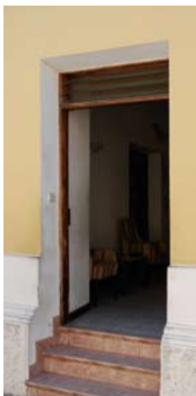
{ FIG. 3.41 } Dispositivos ajustáveis que direccionam o fluxo de ventilação: portadas exteriores venezianas (em cima à esquerda); vãos com partes amovíveis.
