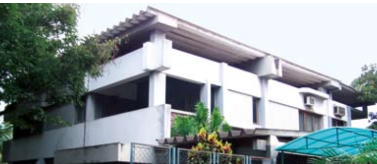
{ FIG. 3.42 } Edifício com cobertura ventilada.
