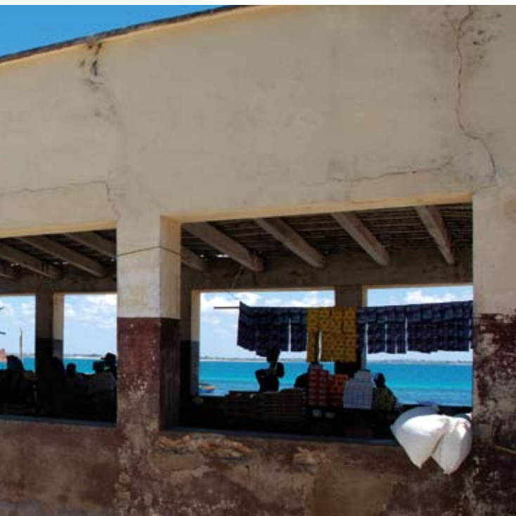
{ FIG. 3.64 } Mercado com ventilação cruzada na Ilha de Moçambique.
