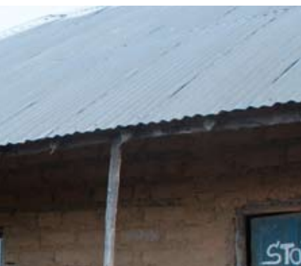
{ FIG. 3.35 } O uso sem protecção (isolamento) de material metálico para coberturas deve ser evitado, dado que leva ao agravamento de situações de sobreaquecimento interno.
