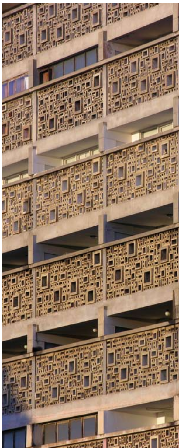
{ FIG. 3.17 } Utilização de “Brise Soleil” para sombreamento de fachada num edifício projectado pelo Arq. Pancho Guedes, em Maputo.
