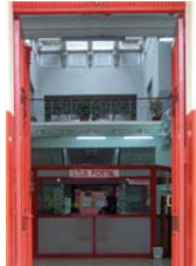
{ FIG. 3.62 } Átrio para iluminação e ventilação natural em dois edifícios, em Maputo.
