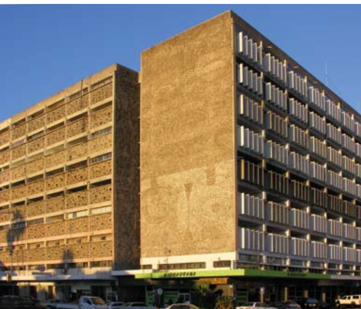
{ FIG. 3.17 } Utilização de “Brise Soleil” para sombreamento de fachada num edifício projectado pelo Arq. Pancho Guedes, em Maputo.
