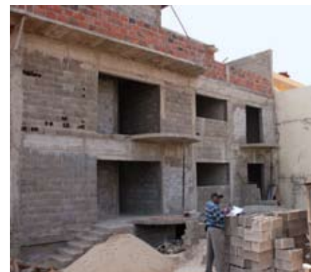
{ FIG. 3.68 } Nova construção, utilizando tijolo e betão.
