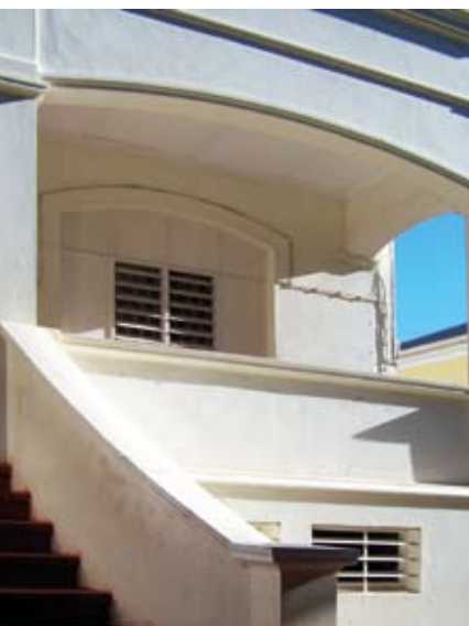
{ FIG. 3.41 } Dispositivos ajustáveis que direccionam o fluxo de ventilação: portadas exteriores venezianas (em cima à esquerda); vãos com partes amovíveis.
