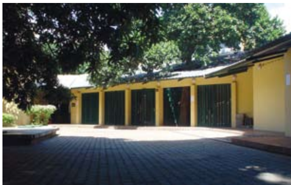
{ FIG. 7.9 } Pátio sombreado da Faculdade de Arquitectura da UEM, em Maputo.
