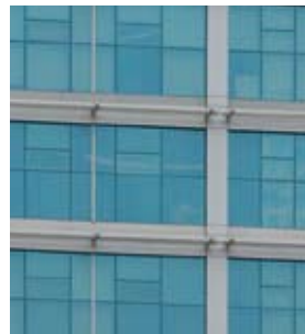
{ FIG. 3.38 } Devem ser evitadas tipologias de fachadas com grandes áreas de envidraçado, largamente responsáveis pelo sobreaquecimento do interior do edifício, e conseqüente recurso a sistemas energívoros de ar condicionado. As fachadas com grandes áreas de envidraçado são uma tipologia importada, não se adequando ao clima quente de Moçambique.
