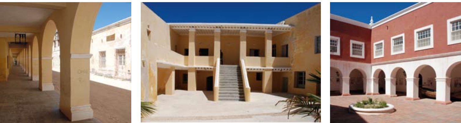
{ FIG. 3.23 } Sombreamento fixo: Arcadas. Ilha de Moçambique (em cima) e Maputo (em baixo).
