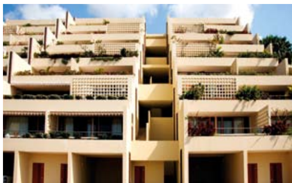
{ FIG. 7.10 } Condomínio do Caracol, em Maputo.
