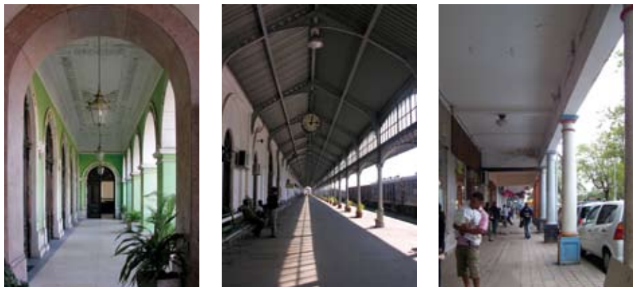
{ FIG. 3.23 } Sombreamento fixo: Arcadas. Ilha de Moçambique (em cima) e Maputo (em baixo).
