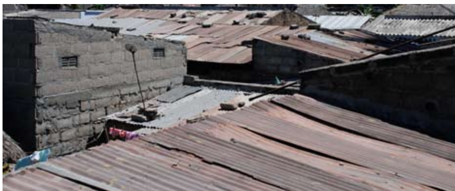
{ FIG. 3.35 } O uso sem protecção (isolamento) de material metálico para coberturas deve ser evitado, dado que leva ao agravamento de situações de sobreaquecimento interno.
