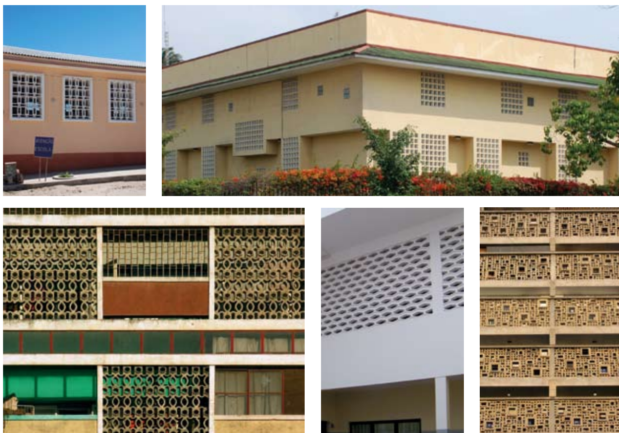
{ FIG. 3.40 } Grelhas de fachada: além de proporcionarem sombreamento e segurança, permitem a ventilação natural.
