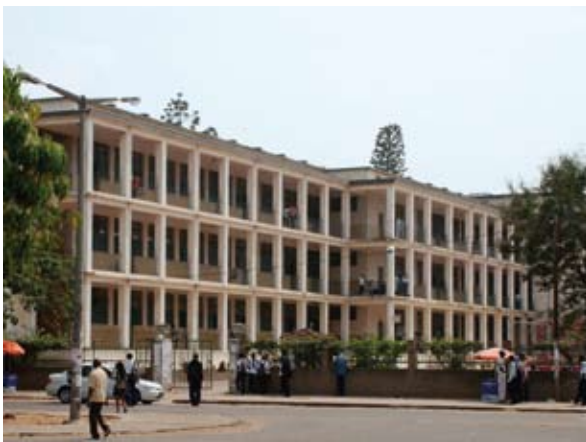
{ FIG. 3.21 } Exemplos de sombreamento fixo por projecção da varanda em edifícios na cidade de Maputo.
