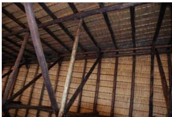
{ FIG. 3.33 } Utilização do colmo em edifícios contemporâneas. Ao utilizar esta tipologia de tradição local, recolhem-se também os benefícios térmicos da protecção solar.
