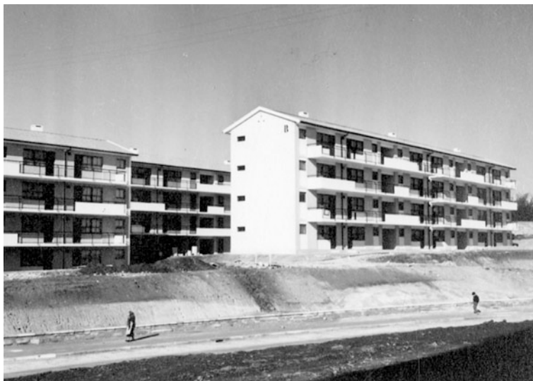
Fig. 8.2 Bairro do Bom Sucesso, 1958, view from the west side. Source Arquivo Histórico Municipal do Porto/Arquivo Geral da Câmara Municipal do Porto (DMESG-11108-002/3)
