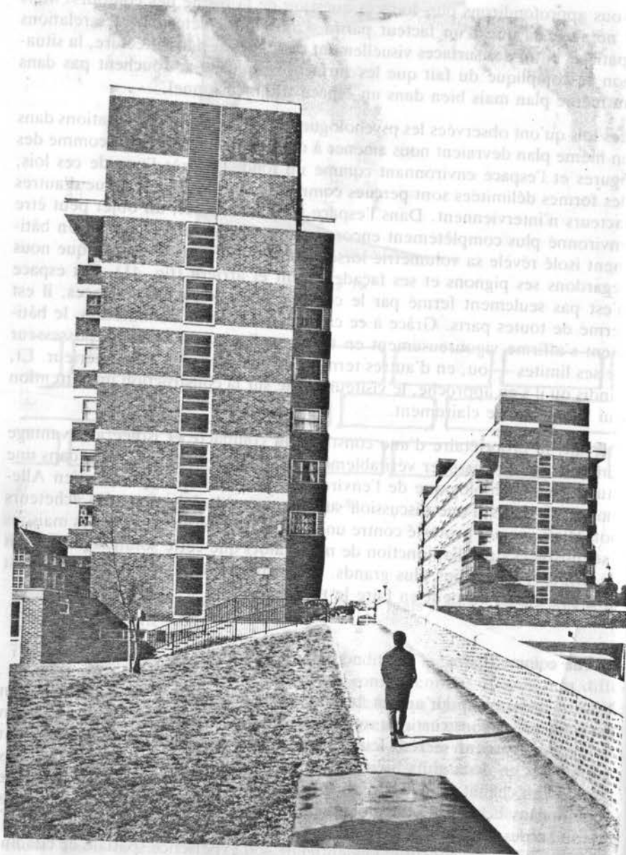
Figure 41. Complexe d'appartements à Islington. Architectes, McMorran et Whitby. Photo, John Gay.
