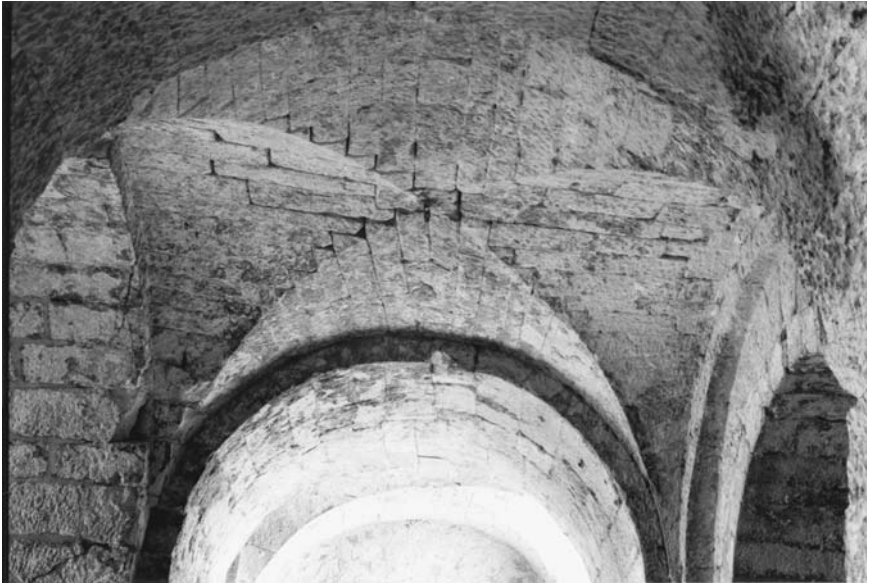
21. Soissons, Saint-Médard, interior, crypt, lateral hall, groin vault.
