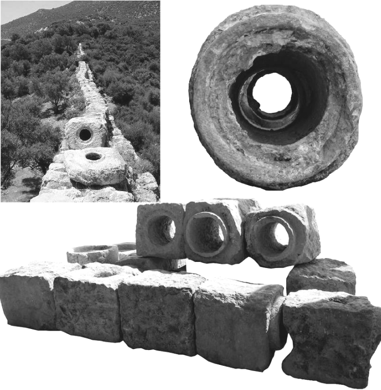
Fig. 8.2 Roman stone pipes.
