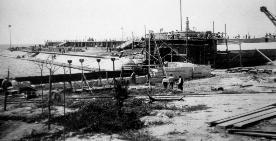
Fig. 2 Construction pier. Costanera Sur. 1919 – Archivo de la Nación. Archivo Fotográfico. Caja 3234
