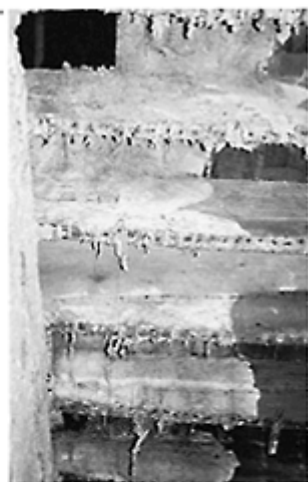
S. lacrymans (dry rot) mycelium in a void.
