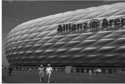
Figure 24. Allianz Arena, Munich.
